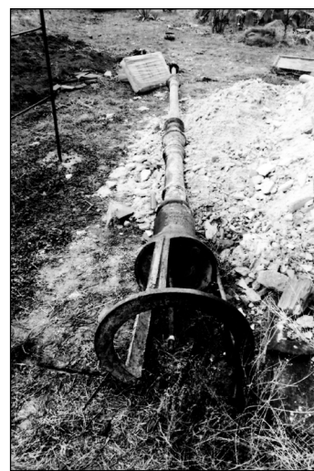
Загальний вигляд дрогобицького газового ліхтаря (без верхньої частини)
